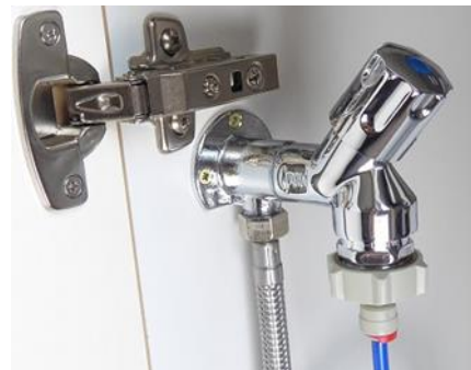
Abb. Eingangsventil EGV-2 Untertisch
